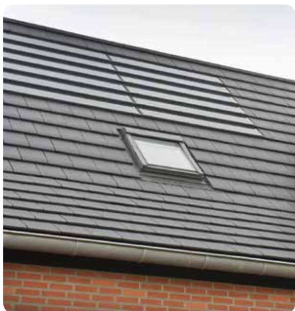
Volledig geïntegreerd PV-systeem Monier VI90, model Signy®
